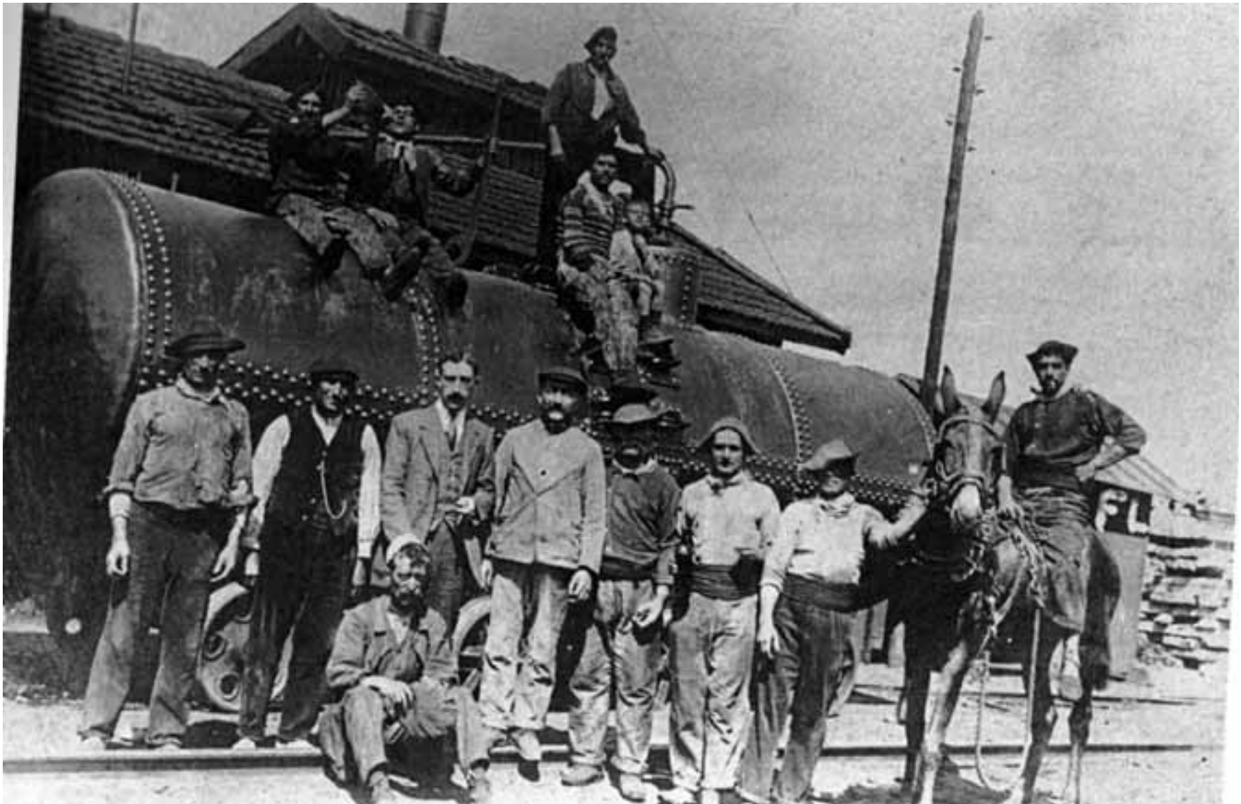
1917 Un grupo de empleados posa junto a uno de los cilindros donde se metían las traviesas para someterlas al proceso del creosotado.
